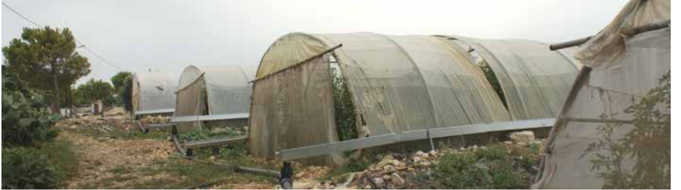
مشروع تجريبي لجهاز تجميع مياه الأمطار على سطوح الخيم البلاستيكية في كفر مسحون - جبيل / بيبيلوس (الصورة من ق. كاباكيان)
